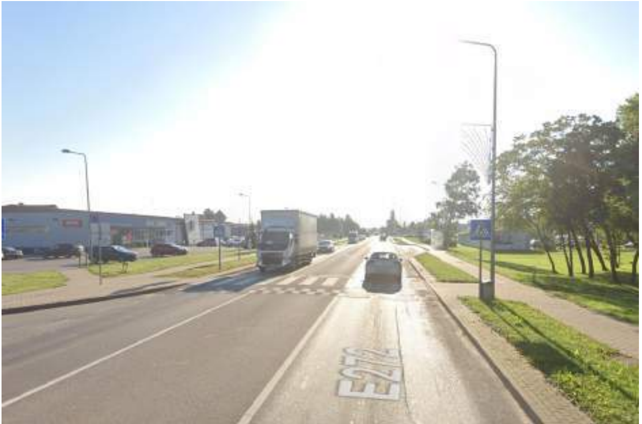
5 pav. Esama perėja ties 134,603 km
