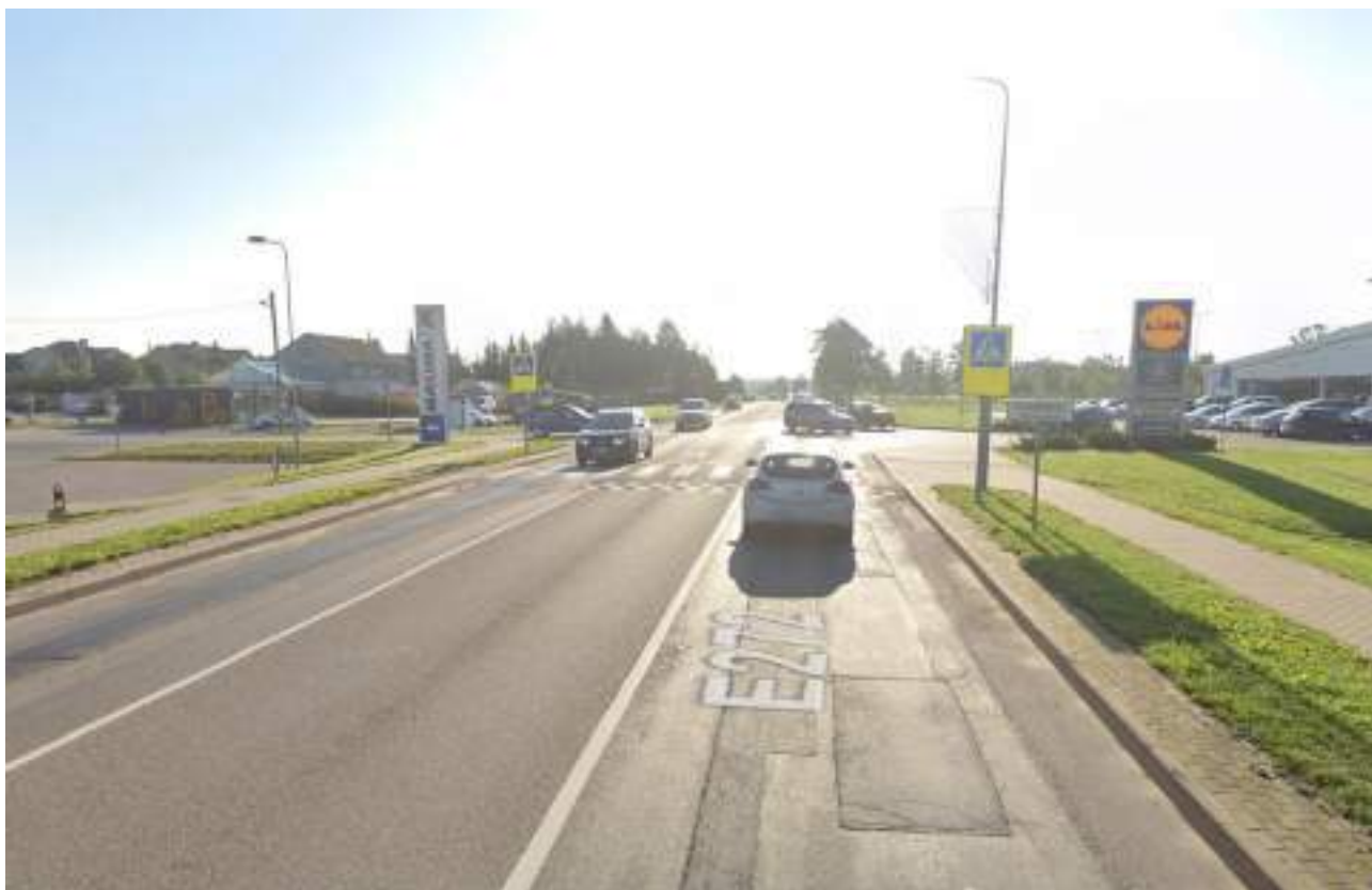
4 pav. Esama perėja ties 134,480 km
